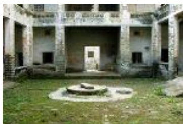
(左圖) 鎮隆古城某宗祠院井
